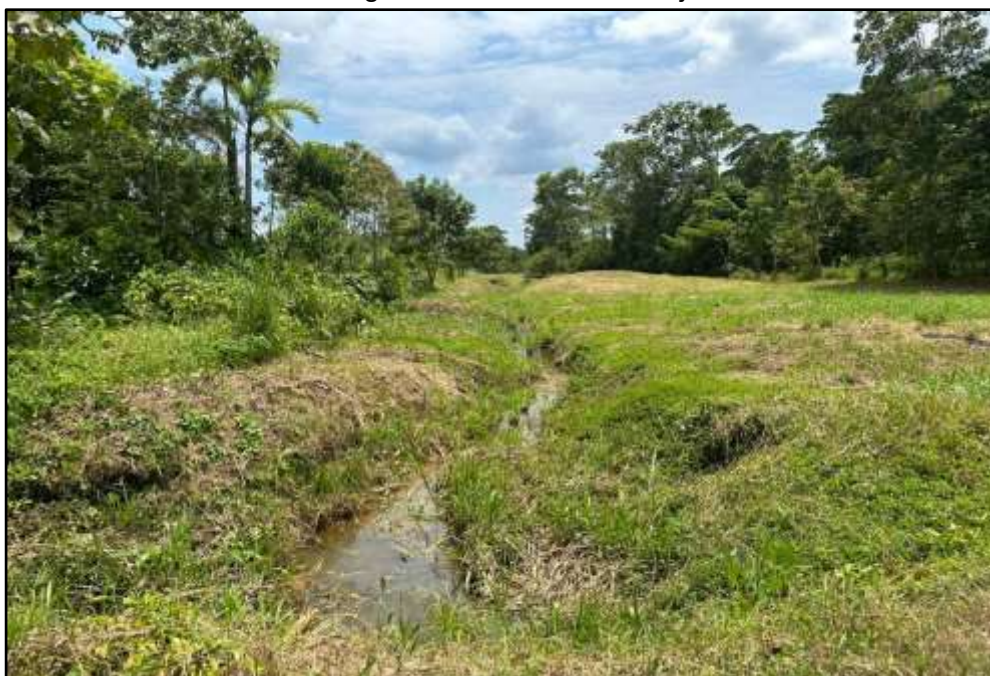
Fotografía 2: Canal de drenaje.
