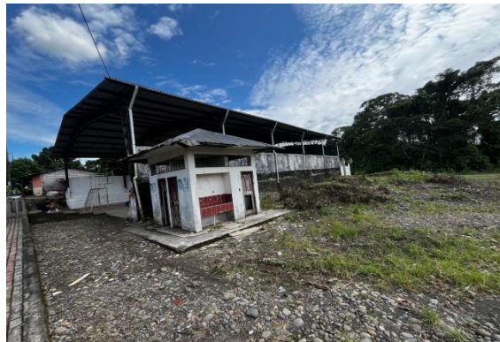
Ilustración 5 Fuente: Inspección en campo lote global
