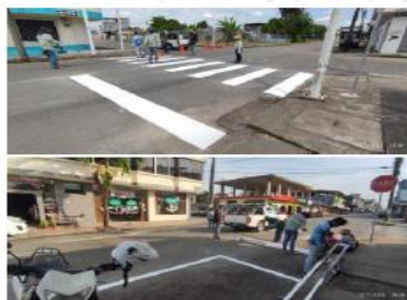
MARCAS VIALES DE PAVIMENTO SUMINISTRO E INSTALACIÓN DE TERMOPLÁSTICO PREFORMADO REFLECTIVO I e=1,5 mm (INCL. PREMIER)
