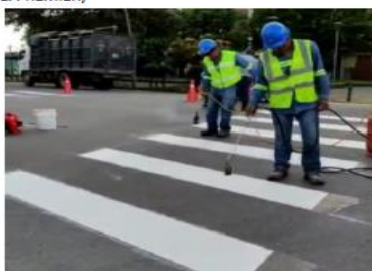
MARCAS VIALES DE PAVIMENTO SUMINISTRO E INSTALACIÓN DE TERMOPLÁSTICO PREFORMADO REFLECTIVO I e=1,5 mm (INCL. PREMIER)
