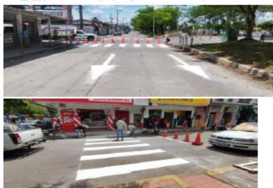
MARCAS VIALES DE PAVIMENTO SUMINISTRO E INSTALACIÓN DE TERMOPLÁSTICO PREFORMADO REFLECTIVO I e=1,5 mm (INCL. PREMIER)
