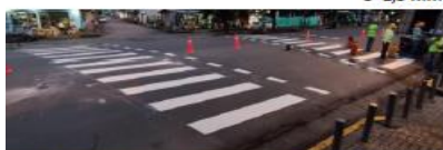
MARCAS VIALES DE PAVIMENTO SUMINISTRO E INSTALACIÓN DE TERMOPLÁSTICO PREFORMADO REFLECTIVO I e=1,5 mm (INCL. PREMIER)
