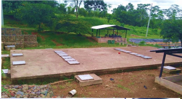
Repotenciación de la planta de tratamiento de aguas residuales (sedimentador)
